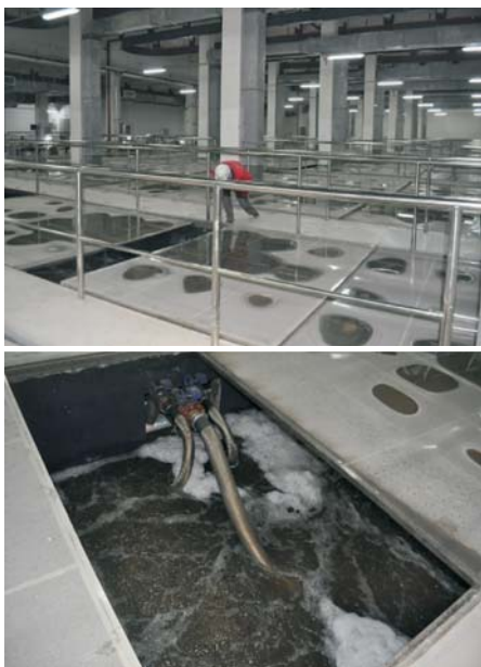
昆明市第十污水处理厂地埋式MBR膜池
